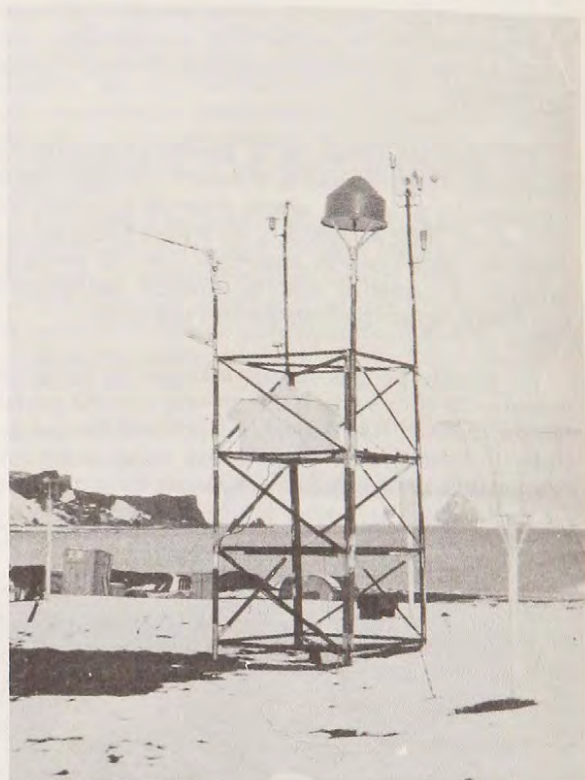
FOTO 1. DCP INSTALADA EN LA BASE TTE. MARSH. Esta fue la primera instalación, realizada en 1978. Nótese las antenas para los satélites Landsat (A) y GOES (B), los mástiles con sensores meteorológicos y la caja protectora que contiene el transmisor y las baterías.
