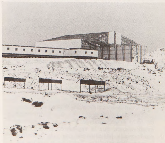
Refugio y hangar construido en Base Marsh, a un costado de la pista de aterrizaje.
