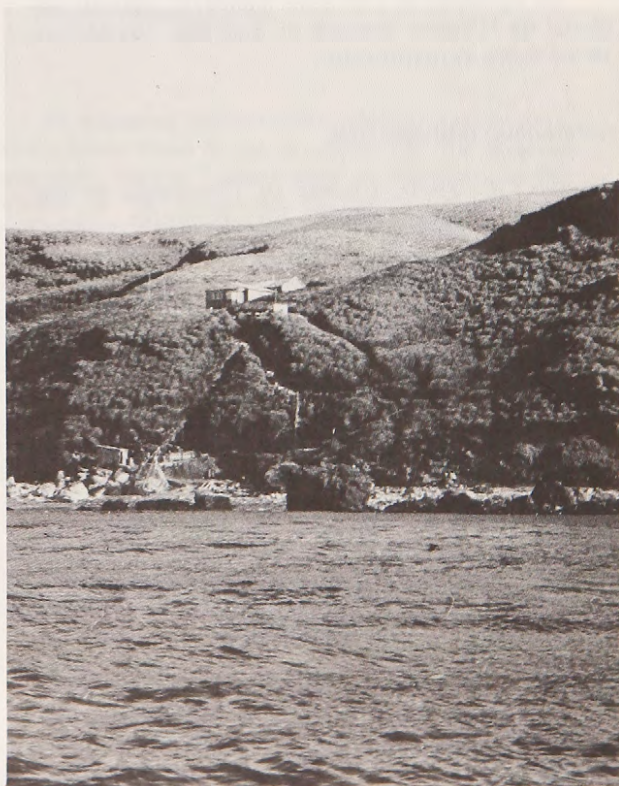
Refugio e instalaciones en Isla Gonzalo.
