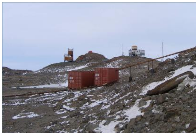
Figura 4. Estación Novolazarevskaya construida con contenedores modulares.
