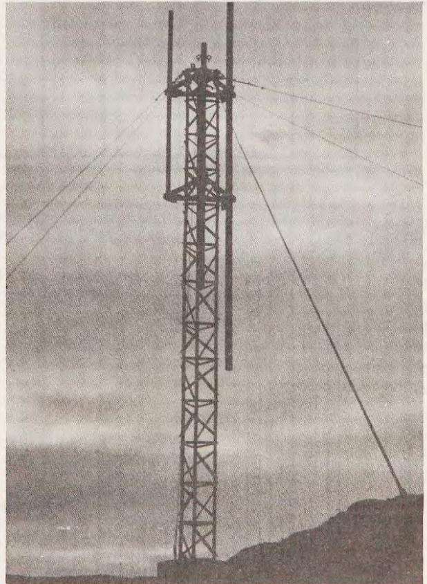
Foto 1. Nueva estructura metálica utilizada para disponer los sensores y demás elementos electrónicos de la DCP instalada en punta Spring (1981).
