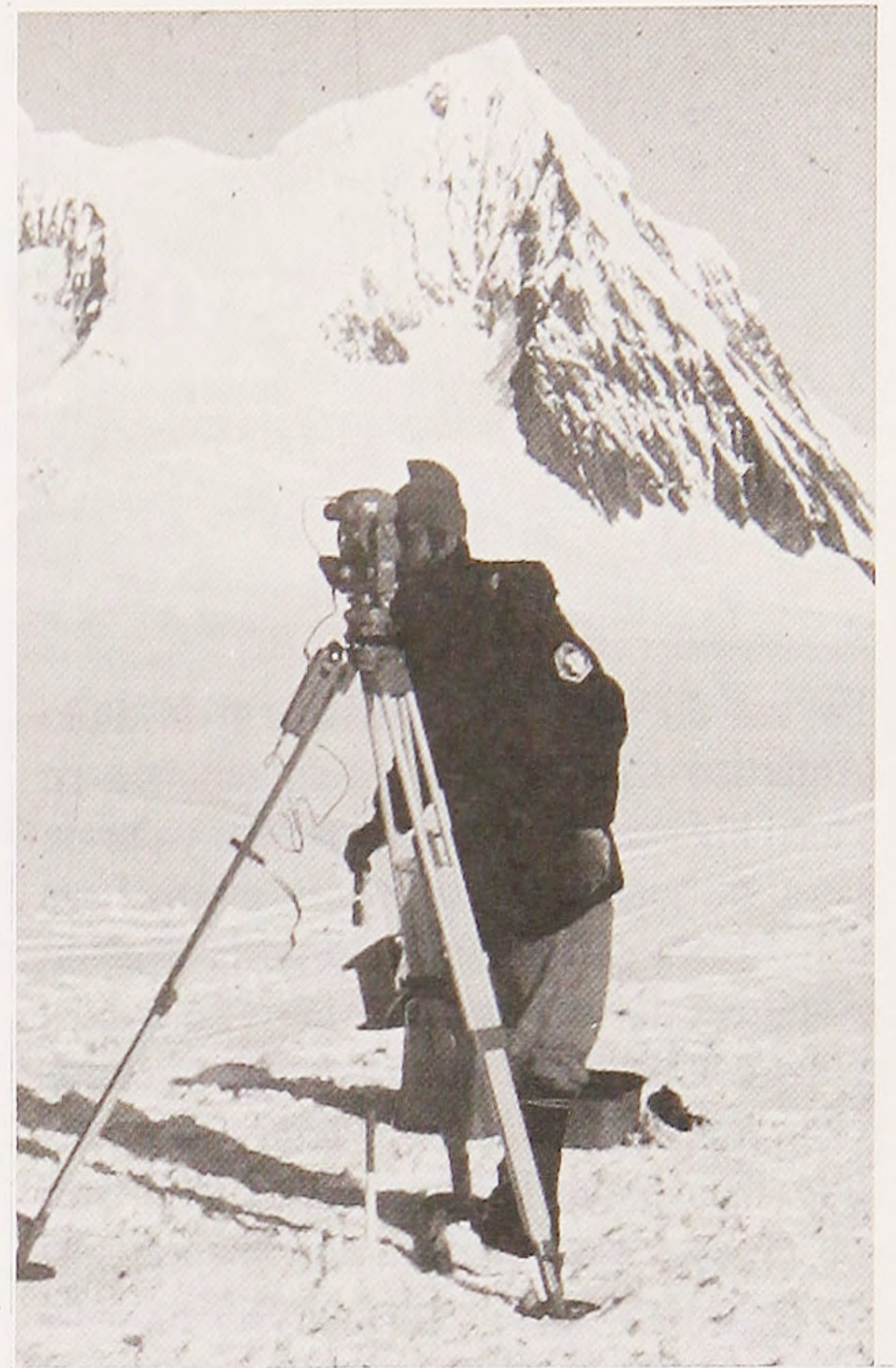
Ing. José Manuel Martín Y., operando un distanciómetro en estudio de movimiento de masas de hielo en el glaciar de isla Anvers. Al fondo el monte Williams.
