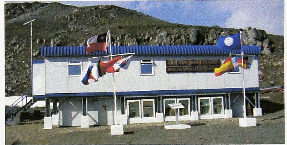
Base "Profesor Julio Escudero" Chile. Prefabricado tipo container. Fuente: www.google.cl
