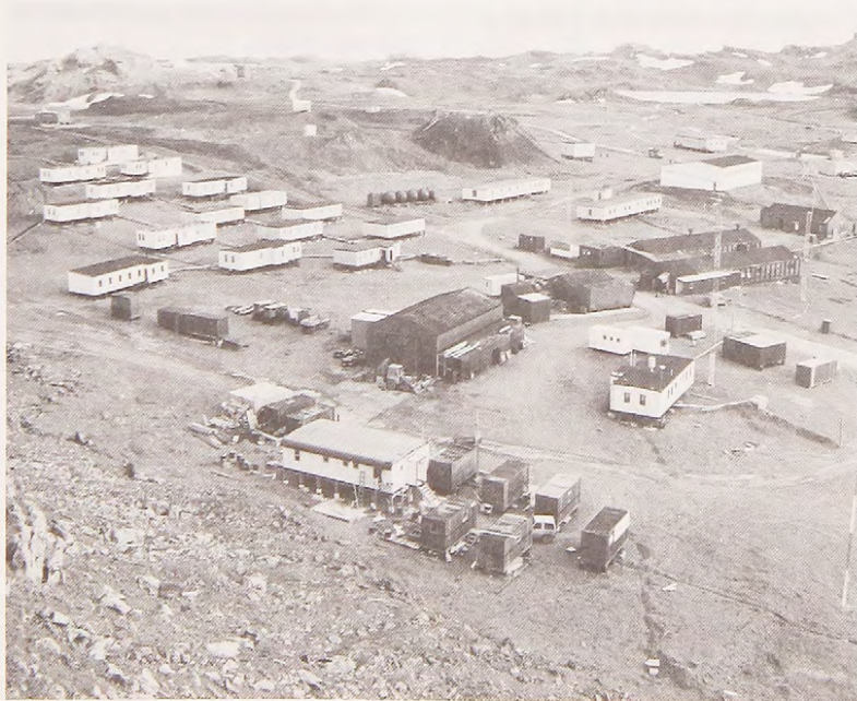
Vista panorámica de la base Presidente E. Frei (ex Tte. Marsh), Villa Las Estrellas y, en primer plano, la Estación Fildes, del INACH. (Foto: Guillermo Muñoz).
