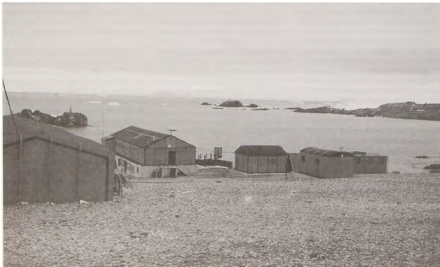
Vista parcial de Base Esperanza (Foto: L. Galleguillos).
