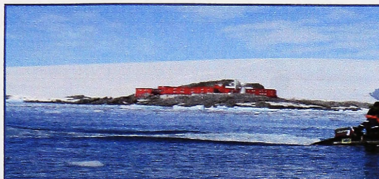
Figura n° 3.8.- Fotografía tomada en enero 2009
