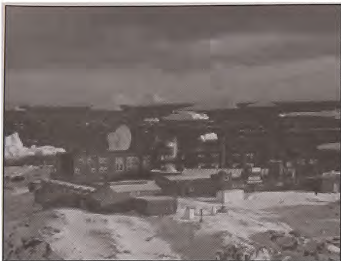
Fig. 2 La nueva base detrás de la base antigua que aún no ha sido demolida.
