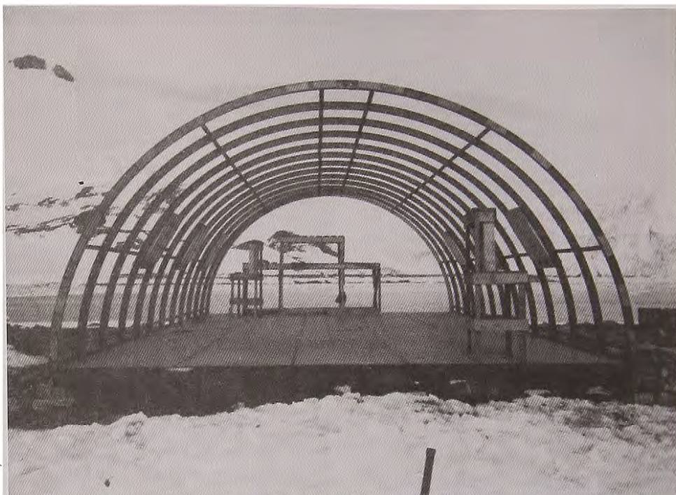
Estructura de la primera casa antártica (Foto gentileza Dr. A. Larraín).
