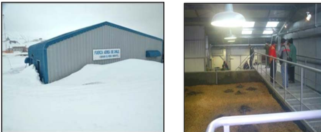
Figura N° 6 Vista exterior e interior de la Planta de Tratamiento de Aguas Residuales o Servidas en la B.A.A.P.E.F.M.
