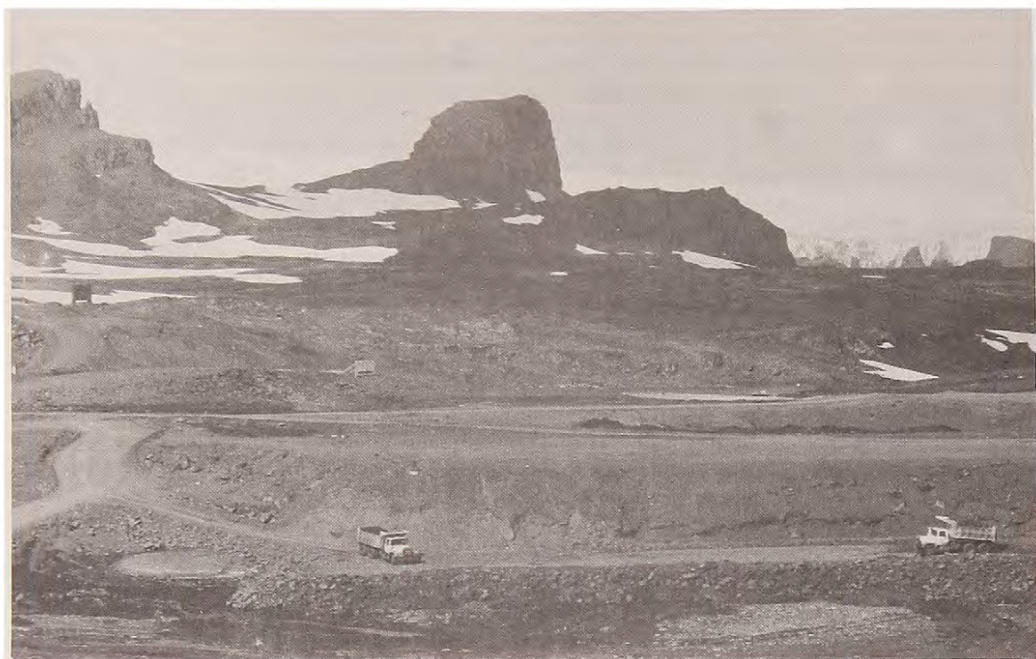
La Dirección de Aeropuertos de Chile tuvo a su cargo la construcción de la pista aérea en isla Rey Jorge.
