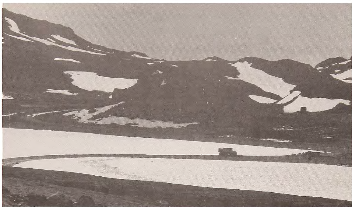
La construcción de la pista aérea en la Base Teniente Marsh, ha sido una de las más importantes obras de infraestructura efectuadas en el Territorio Antártico.
